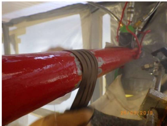
Foto 2: reinigen van het vlak waar afstandhouders zat
