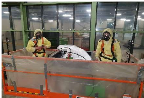
Foto 7: opstelling in een hoogwerker
