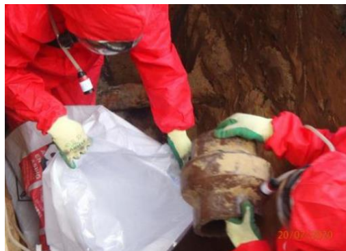
Foto 6: mofverbinding tussen twee buizen uitgesneden
