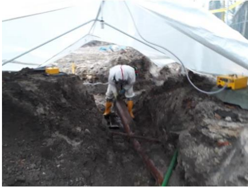
Foto 20: Lostrekken van de gresbuis
