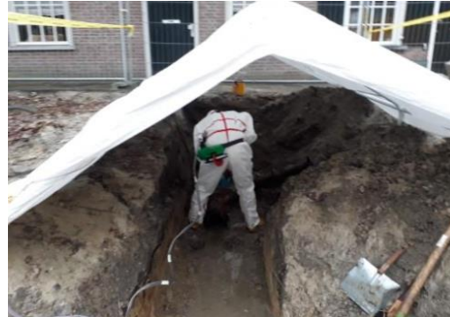
Foto 16: Tent Reitse Hoevenstraat te Tilburg (onderzoek 3)
