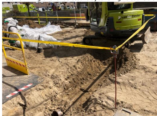
Foto 26: Minigraver ondersteunt bij sanering huisaansluiting
