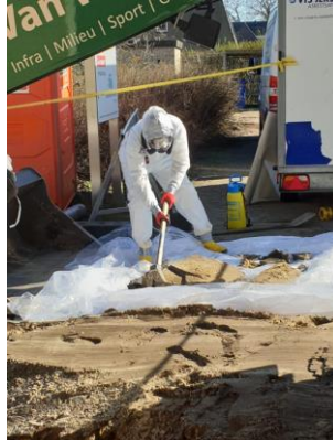
Foto 10: Verwijderen van vaar- en moereinden
