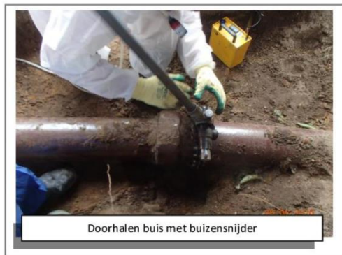
Foto 28: Doorhalen met de buizensnijder
