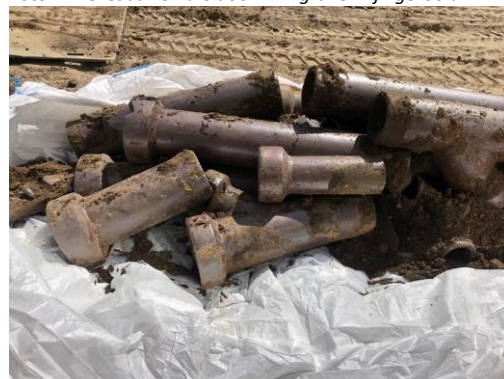
Foto 27: Gresbuizen die door minigraver zijn gerooid
