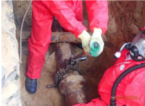
Foto 5: ketting aangebracht t.b.v. snijden van de buis
